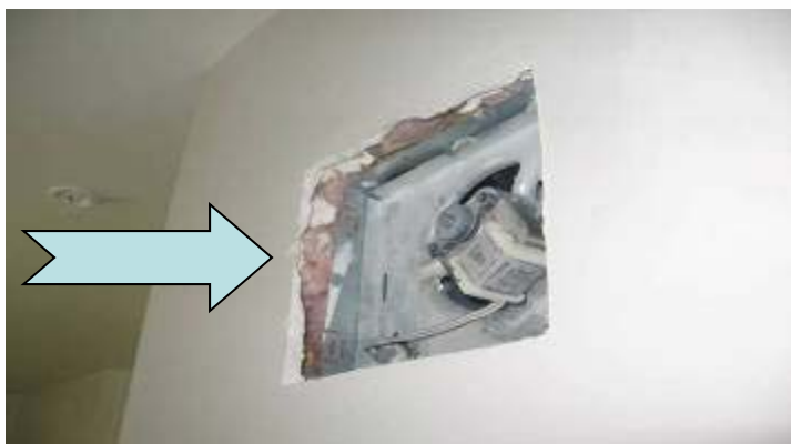
Bathroom Exhaust Fan
